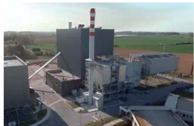
Chaudière biomasse valorisant les déchets en bois d'une exploitation forestière locale et qui alimente en vapeur l'usine Bonduelle d'Estrées-Mons (France).
