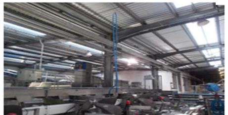
Suppression des tuyaux au sol
